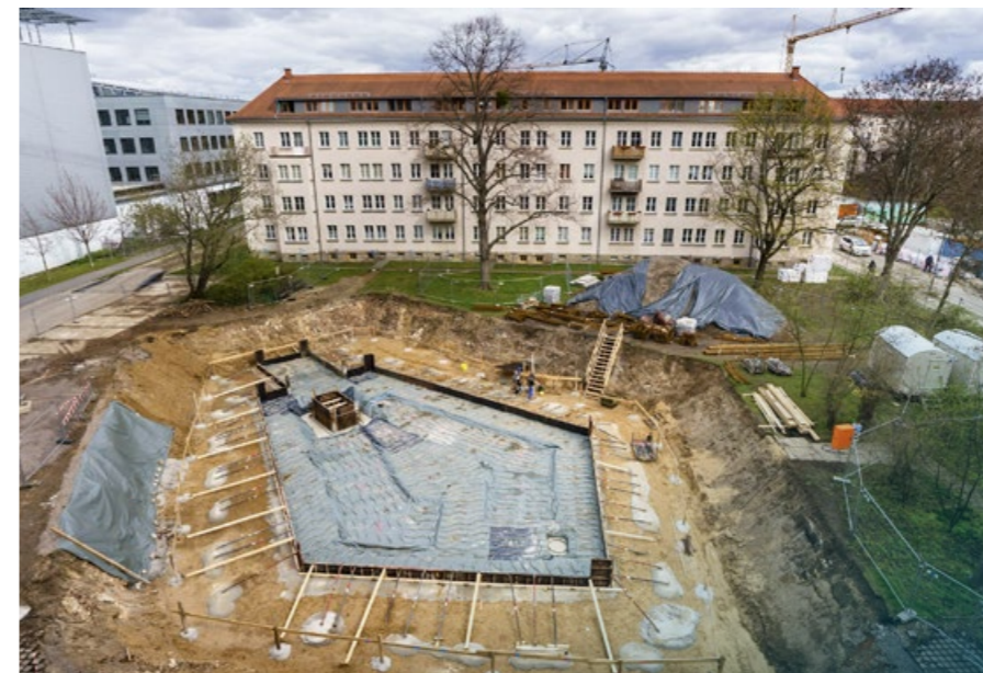
Die Arbeiten an den Häusern nördlich der Seidnitzer Straße haben begonnen
