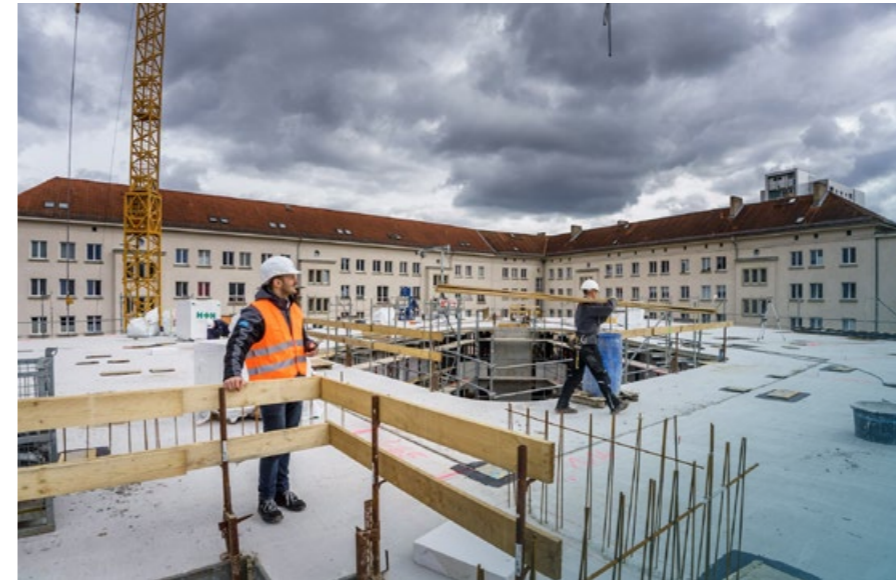
Bei Haus L laufen die Arbeiten an den oberen Etagen
