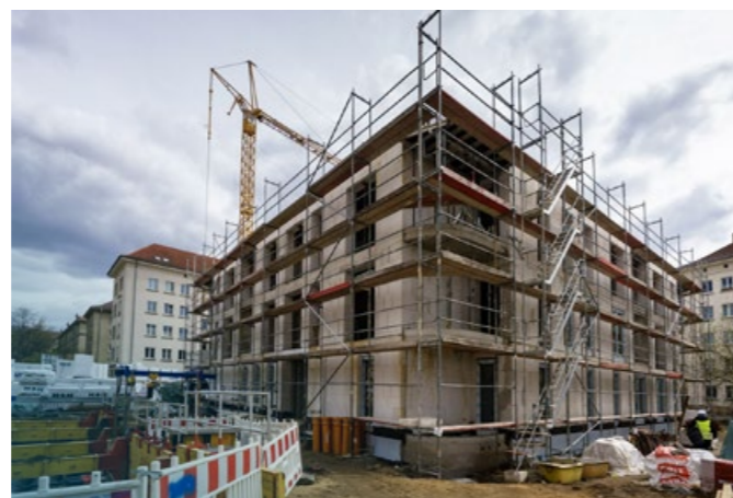
Der Hochbau von Haus L ist fast abgeschlossen
