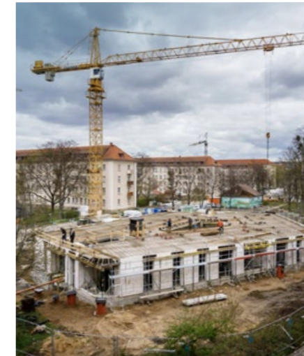
Blick auf die Baustelle von Haus M
