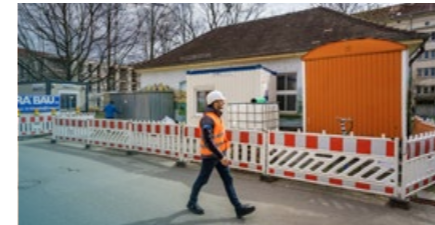
Unterwegs zwischen den Baufeldern
